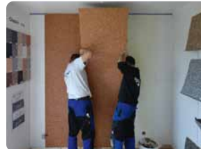
Schritt 5. zugeschnittenes Heizelement mit 2 Personen anheben, auf die Unterlaghölzer aufsetzen, senkrecht ausrichten, an die Wand andrücken und gleichmäßig festdrücken. Danach die nächste Reihe auf die mit Kleber aufgekämmte Fläche ansetzen und festdrücken.
