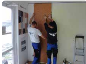
Schritt 5. zugeschnittenes Heizelement mit 2 Personen anheben, auf die Unterlaghölzer aufsetzen, senkrecht ausrichten, an die Wand andrücken und gleichmäßig festdrücken. Danach die nächste Reihe auf die mit Kleber aufgekämmte Fläche ansetzen und festdrücken.
