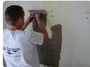
Schritt 4. Kleber auftragen (mit Zahnkelle 10mm) Verbrauch ca. 4kg/m 2
