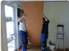
Schritt 5. zugeschnittenes Heizelement mit 2 Personen anheben, auf die Unterlaghölzer aufsetzen, senkrecht ausrichten, an die Wand andrücken und gleichmäßig festdrücken. Danach die nächste Reihe auf die mit Kleber aufgekämmte Fläche ansetzen und festdrücken.
