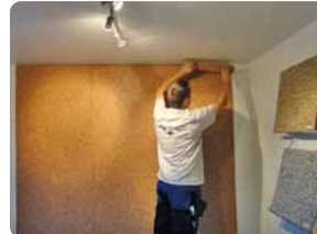
Schritt 5. zugeschnittenes Heizelement mit 2 Personen anheben, auf die Unterlaghölzer aufsetzen, senkrecht ausrichten, an die Wand andrücken und gleichmäßig festdrücken. Danach die nächste Reihe auf die mit Kleber aufgekämmte Fläche ansetzen und festdrücken.
