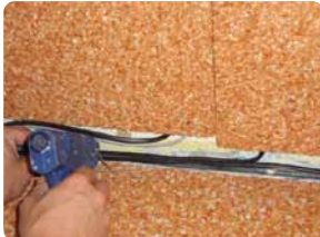
Schritt 6. Die Kabel im Sockelbereich verlegen, z.B. mit Heißkleber.
