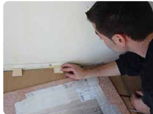
Schritt 3. Abstandsklötzer (ca. 5cm hoch) unterlegen, als Auflage der Heizelemente
